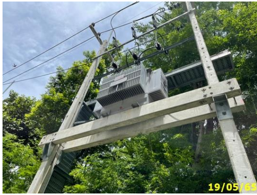
หม้อแปลงไฟฟ้า พร้อมตู้ควบคุมไฟฟ้า
