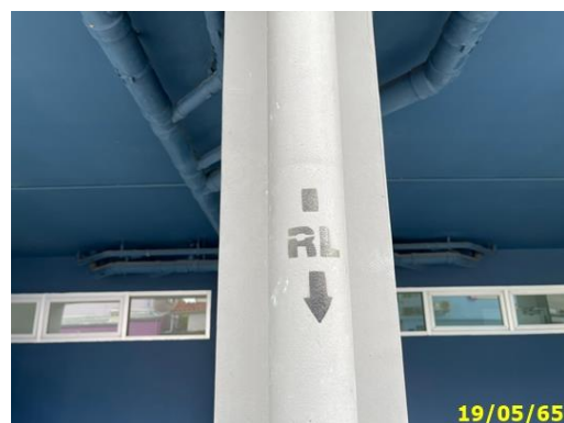
ท่อรวบรวมน้ำทิ้งและน้ำฝน
